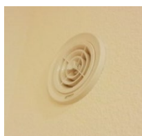
換気口が閉まっている状態。
